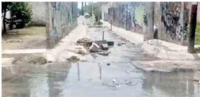
■ Por la deficiencia del drenaje, el agua se va a otras calles.
