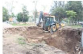
ÁREAS VERDES. Las obras incluirán la colocación de caminamientos especiales, para que la gente pueda hacer ejercicio.
