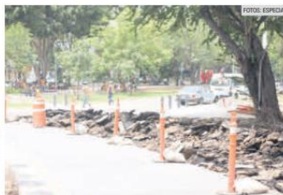
TRABAJOS. Las obras incluyen la rehabilitación de la carpeta asfáltica.
