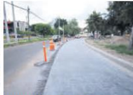
MATERIALES. Están metiendo concreto con una durabilidad de 30 años.
