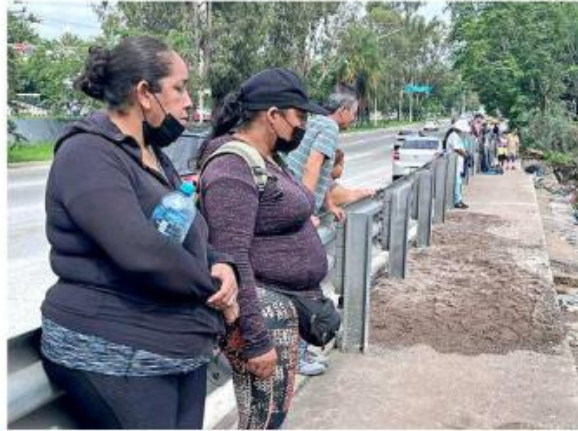
■ El auto de Eugenio fue jalado por el agua hacia un canal cerca de la Calle Cuquíuo.
