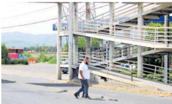
Aunque sean avenidas de riesgo para los peatones, no usan los puentes
