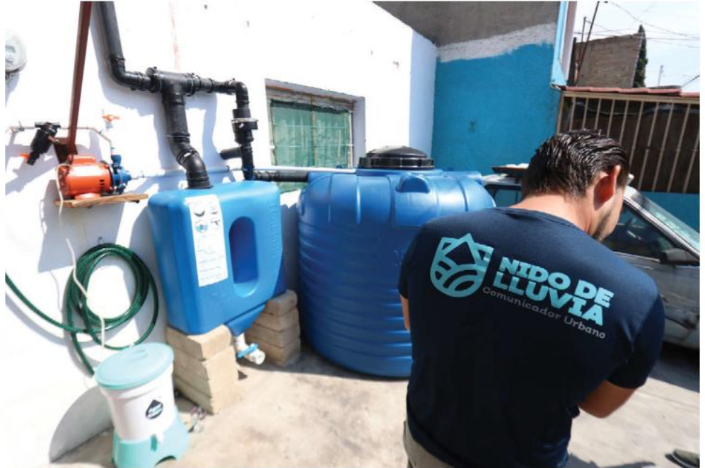
Los Nidos de Lluvia tiene la capacidad de almacenar hasta 2 mil 500 litros de agua. ESPECIAL
