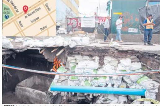
RIESGO. Autoridades y constructores del edificio comenzaron ayer con la reparación del socavón que se formó a causa de las lluvias en el carril lateral de la Avenida Mariano Otero.
