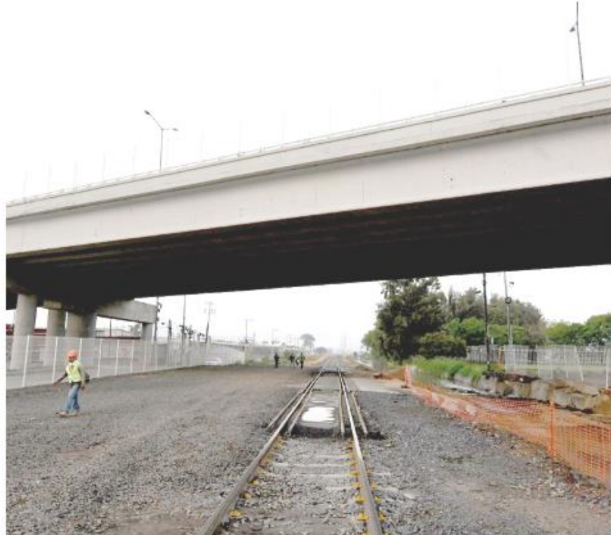
La obra registra un avance del 27 por ciento.
