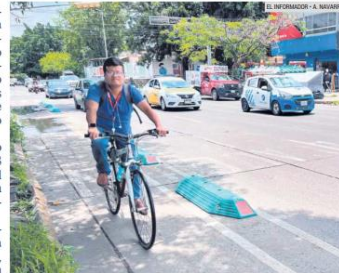
APROVECHAN. Pese a que todavía no se inaugura, los habitantes ya circulan por la nueva ciclo vía que las autoridades construyeron en Avenida Javier Mina.
