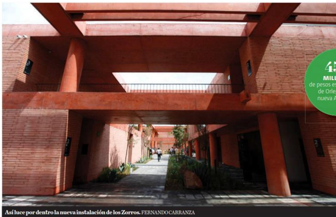
Así luce por dentro la nueva instalación de los Zorros. FERNANDO CARRANZA
