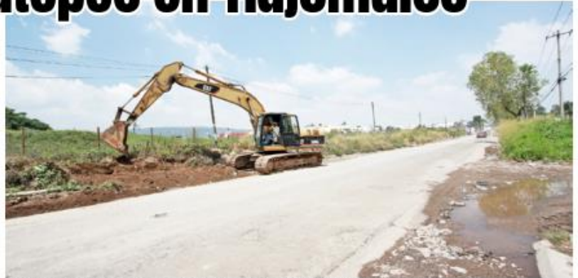
En las siguientes dos etapas de la obra no será necesario realizar cierres viales.
