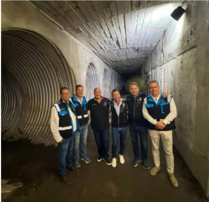
El gobernador Enrique Alfaro informó que el colector requirió de una inversión de 168 millones de pesos. ESPECIAL
