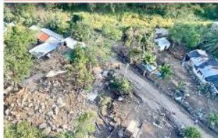
Un total de 54 viviendas resultaron afectadas, de las cuales cuatro fueron declaradas como pérdida total.
