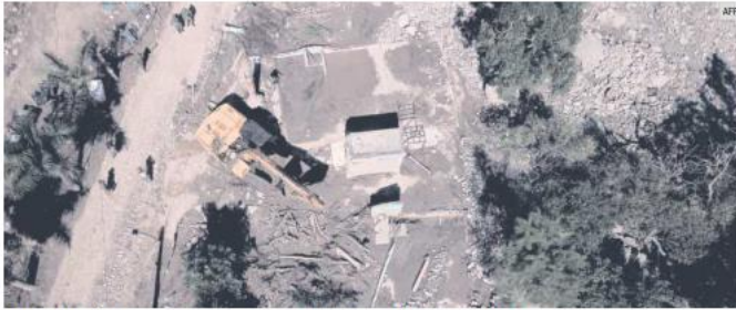
DEVASTACIÓN. En los alrededores de varias viviendas han trabajado con maquinaria pesada.
