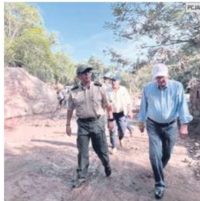
LABOR. Los tres niveles de Gobierno trabajan en la zona afectada.
