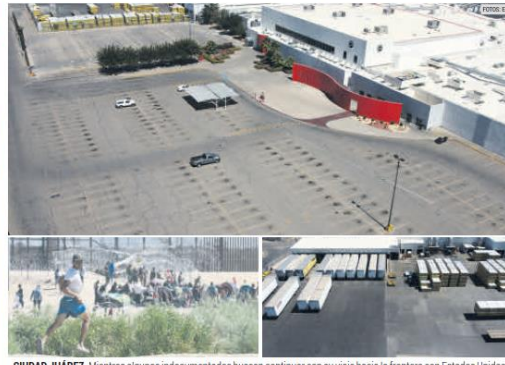
CIUDAD JUÁREZ. Mientras algunos indocumentados buscan continuar con su viaje hacia la frontera con Estados Unidos, hay fabricas ubicadas en Ciudad Juárez que han comenzado a enfrentar problemas en su producción.
