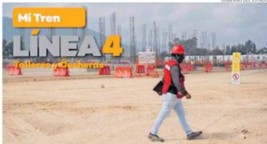
Avanzan las obras de la Línea 4 del Tren Ligero
