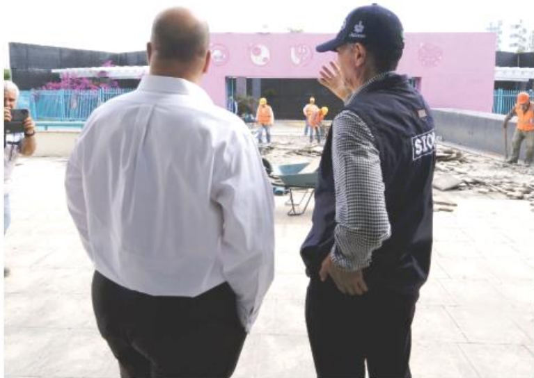
Las obras están a cargo de la Secretaría de Infraestructura y Obra Pública.
