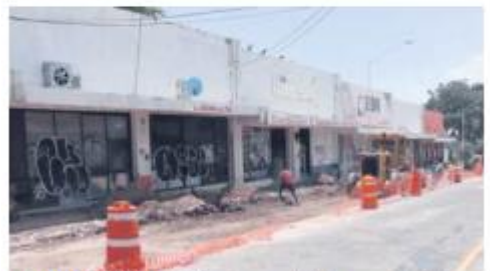
REPARACIÓN. El último tramo del Paseo Alcalde se encuentra en remodelación.
