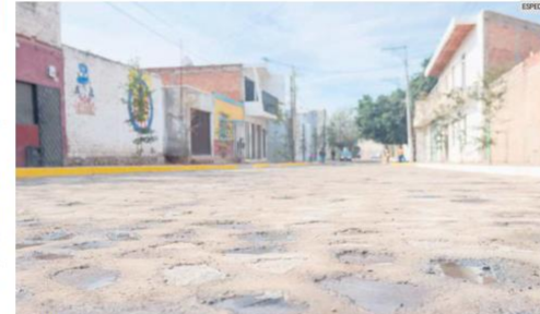
CAMBIO. Las calles en la zona del Sauz fueron remodeladas
