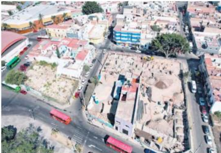
OBRAS. En la zona del Parque Morelos ya se encuentran en desarrollo las construcciones verticales para cumplir con el propósito de repoblar el Centro.
