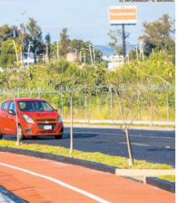
ESTRENAN VÍA. La intervención de los gobiernos y la iniciativa privada permitirá mejorar los traslados de los automovilistas en el poniente de la ciudad.
