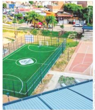
Se ha realizado construcción de infraestructura de primer nivel.
