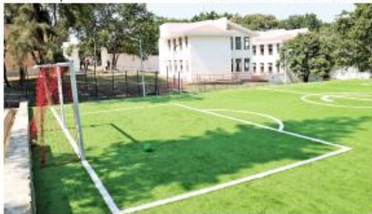
Entre otras mejoras hechas destacan cuatro villas rehabilitadas en su totalidad.
