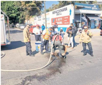
SUPERVISIÓN. Trabajadores del SIAPA y de Protección Civil llevaron a cabo labores de revisión en diversos puntos para descartar riesgos para la ciudadanía.
