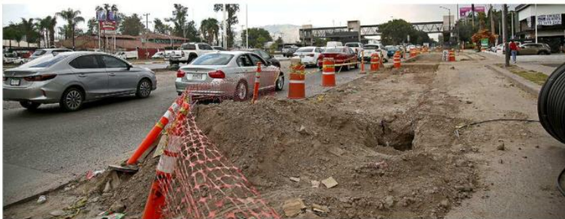
Los trabajos son para rehabilitar banquetas que conectan con Mi Macro Periférico.
