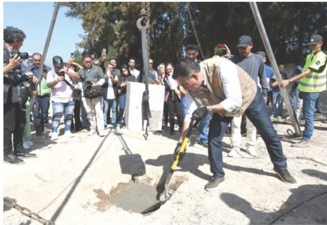
Estará concluido en aproximadamente 4 meses.
