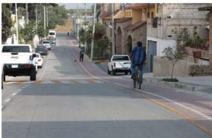
OBRAS. El gobierno de Zapopan entregó este martes la rehabilitación de las calles Hidalgo y Felipe Ángeles de la colonia El Mante. La obra tuvo una inversión total de 67 millones de pesos.
