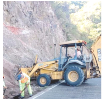
Los trabajos de conservación rutinaria se realizarán de febrero a diciembre del 2024.
