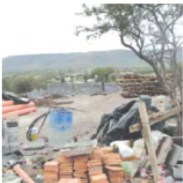
EN EL NORTE. El fraccionamiento en obras clausurado está en la cabecera municipal de Huejúcar.
