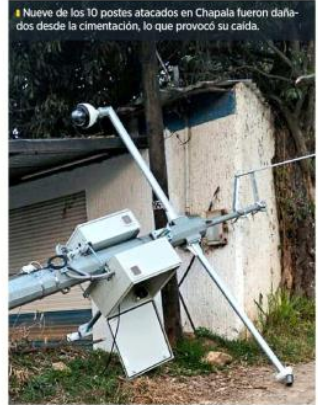
■ Nueve de los 10 postes atacados en Chapala fueron dañados desde la cimentación, lo que provocó su caída.
