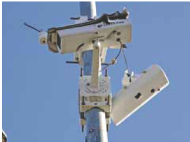
Daño. El vandalismo en el equipo será investigado. CUARTOSURCO ILLUSTRATIVA
