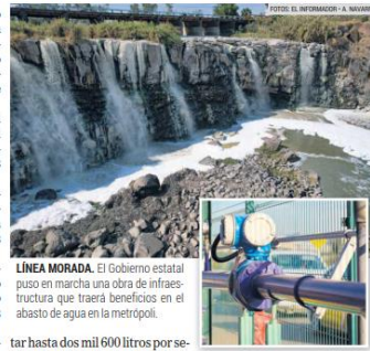
LÍNEA MORADA. El Gobierno estatal puso en marcha una obra de infraestructura que traerá beneficios en el abasto de agua en la metrópoli.
