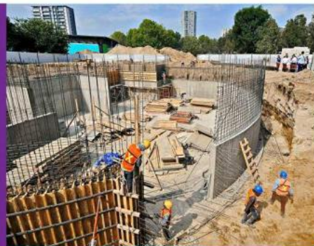
El Museo Trompo Mágico atraviesa una renovación total. Desde el 2022 se han presupuestado casi 650 millones de pesos en las obras.
