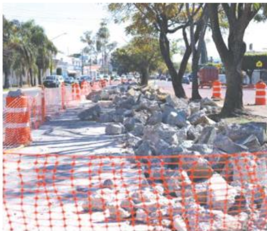
POR EL MUNICIPIO. Las obras actualmente están detenidas en Copérnico.
