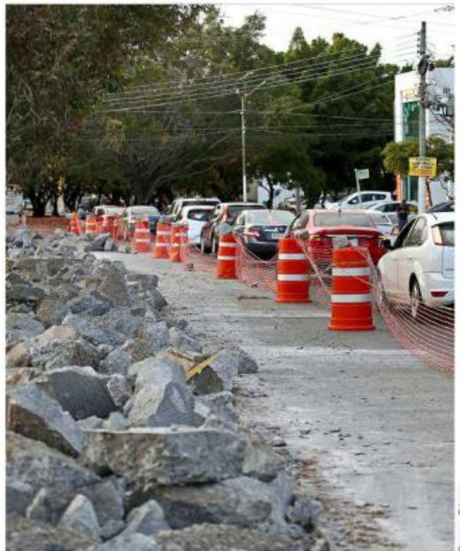
Las obras se reanudarán el lunes 15 de enero.
