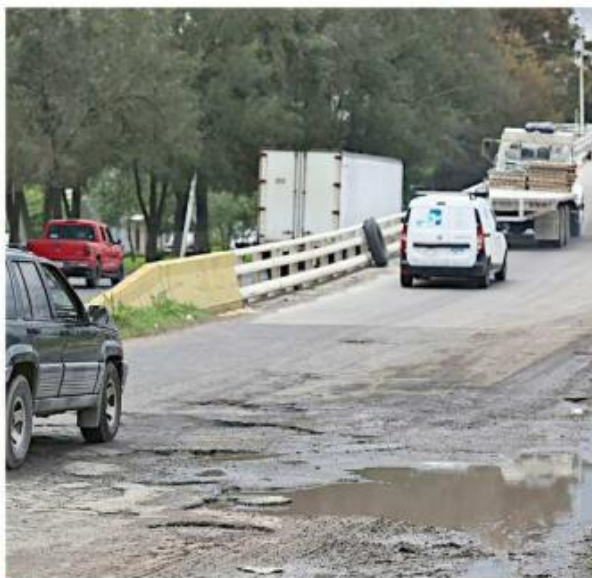
Renovarán la red carretera estatal.
