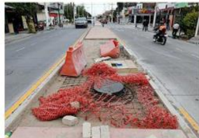
La intervención va de Avenida los Cerezos a Servidor Público.
