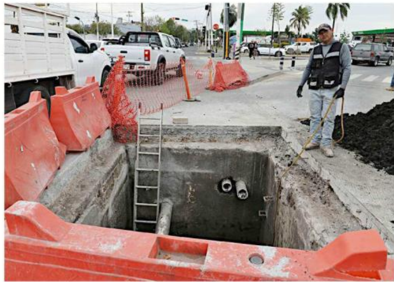
La vialidad está abierta debido a que los trabajos continúan.
