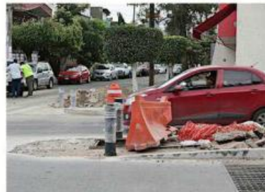
La obra contempla concreto hidráulico y banquetas con accesibilidad universal.
