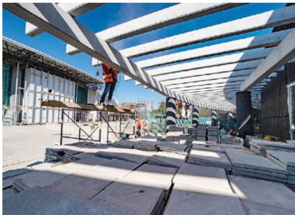
Los trabajos se realizan en tiempo y forma. ESPECIAL
