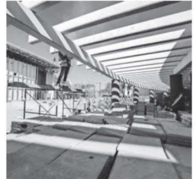
Las obras de remodelación estarán el 30 de abril.
