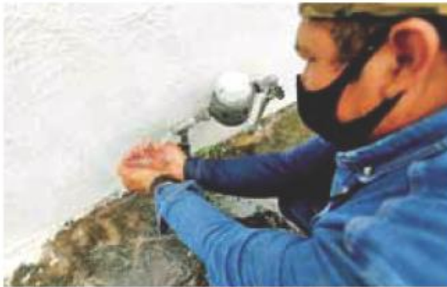
Atención. Realizan reparaciones de fuga en la ZMG. / CORTESÍA
