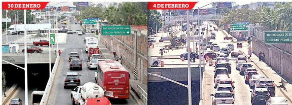
Las modificaciones desquiciaron el tráfico, por lo que ayer se realizaron obras para regresar el proyecto a su estado anterior.
