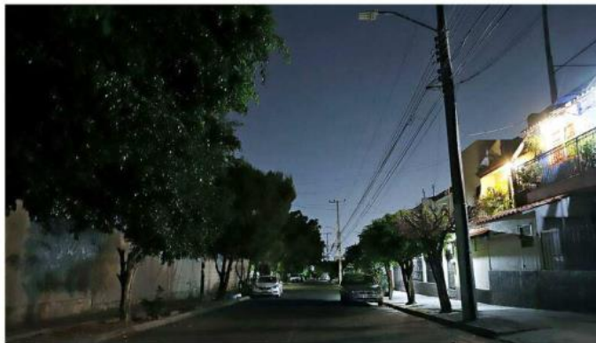
■ Varias de las lámparas están dañadas o son obsoletas.
