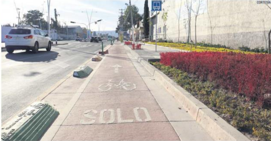
Las laterales de Mariano Otero, una de las obras destacadas de la actual administración, con la renovación de 1.8 kilómetros y cuatro carriles nuevos, además de infraestructura ciclista agregada.
