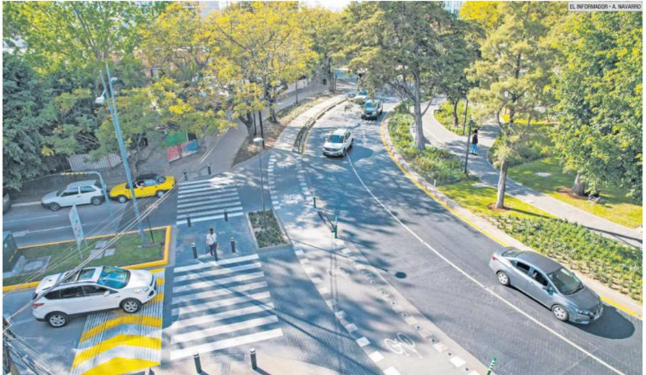
NUEVO ROSTRO. La obra incluyó la remodelación de varias zonas aledañas a la Glorieta Monraz.
