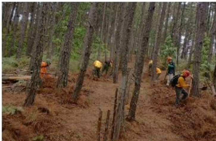
TRABAJOS. Como parte de las acciones para contrarrestar la temporada de estiaje, la Secretaría de Medio Ambiente rehabilitó una brecha cortafuego en el paraje Cerro La Rosilla, en Etzatlán.
