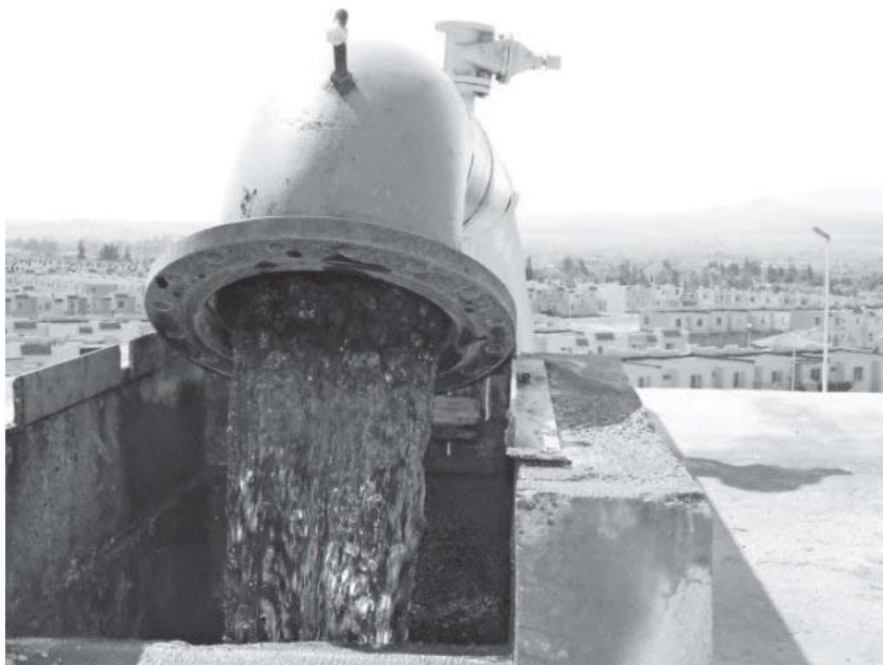
En Tlajomulco inició las obras en materia de agua. /FOTOS GOBIERNO DE JALISCO
