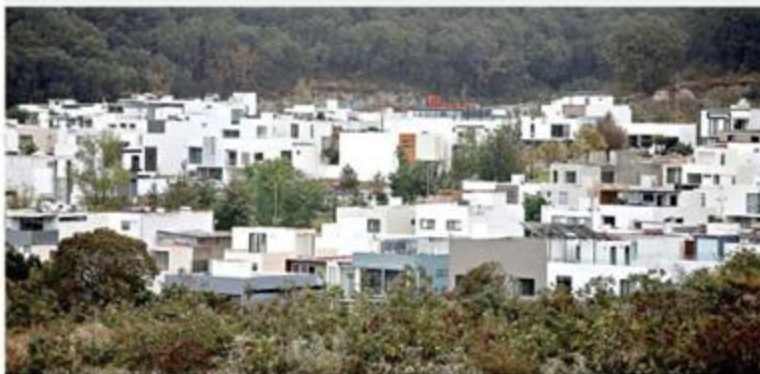
■ Hay construcciones clandestinas dentro del área protegida.
