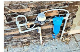
Aun en la banqueta, un usuario hizo una instalación para que no se registre en su cuenta todo el flujo de agua.
