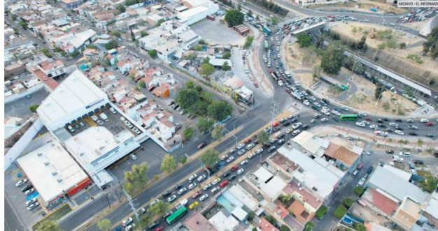
TRAFICO. En la ciudad hay varios cruces peligrosos, donde no se observan agentes viales. En la foto, Alcalde y Periférico.
