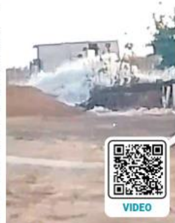
FALLA. La fuga se registró en Tepatitlán un día después de la inauguración del acueducto.
