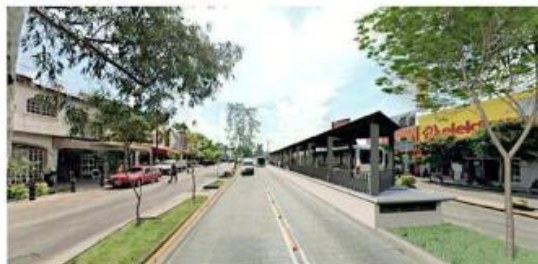
■ Prevén concluir el BRT en Tonalá antes de que termine la actual Administración.
