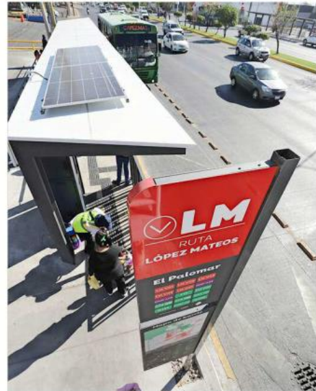
Algunas paradas cuentan con máquinas de recarga.
