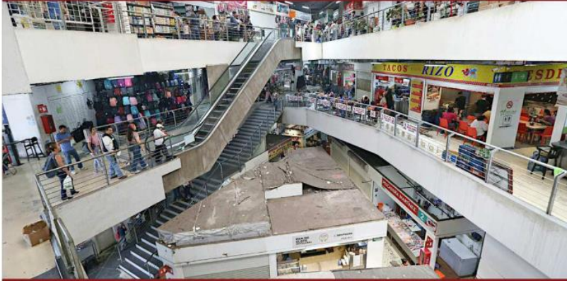
En el techo de algunos locales se puede apreciar basura.
