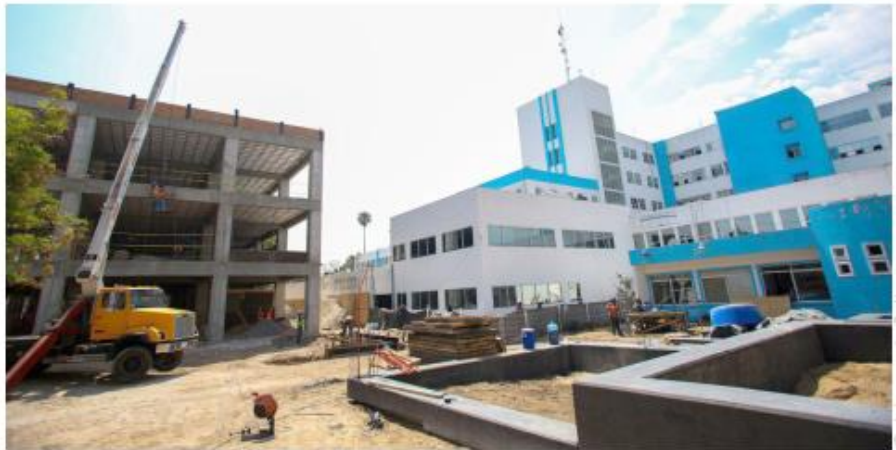
La estructura de concreto está completada al 90 por ciento.
