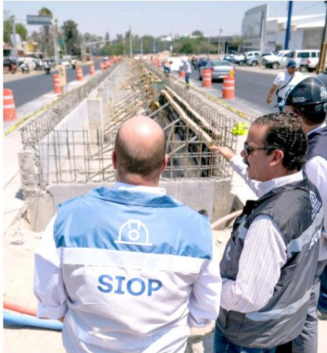
Las estaciones Colonia Jalisco y Los Conejos, avanzan con un 25 por ciento de obra.
