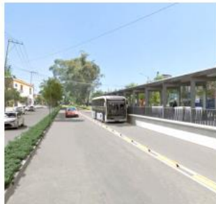
Las estaciones Colonia Jalisco y Los Conejos, avanzan con un 25 por ciento de obra.
