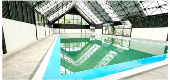
Enrique Alfaro informó que la alberca olímpica ya está rehabilitada al 100%
