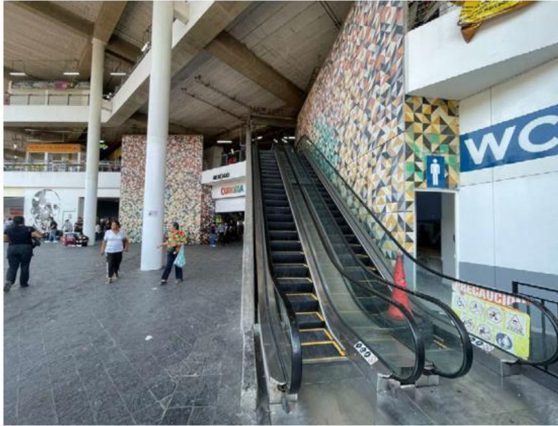
Debido a las fallas en las escaleras eléctricas, comerciantes reportan bajas ventas. K.V. RODRÍGUEZ
