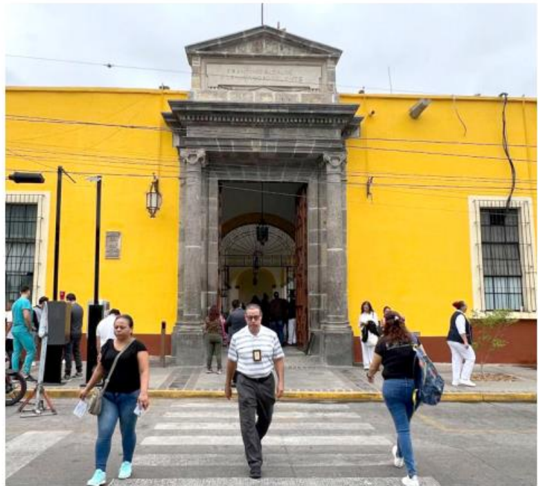
Se respetaron los procedimientos constructivos originales y la importancia del recinto.
