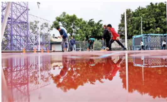
Fueron invertidos más de 16 millones de pesos para la rehabilitación del espacio.
