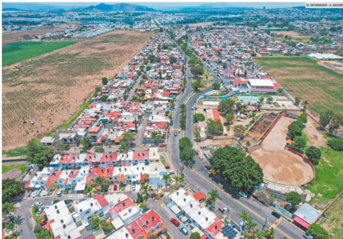
PROBLEMA. En los desarrollos ubicados en los alrededores de la Carretera a Colotlán, el principal problema es la falta de agua. Por eso se prohibió la construcción de más casas.
