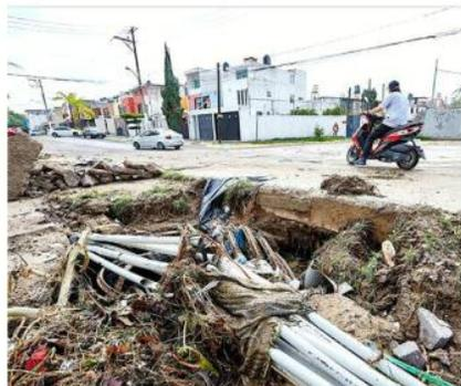
Se rompió parte de la tubería de un cauce en Villas del Ixtépete, dejando cables expuestos.
