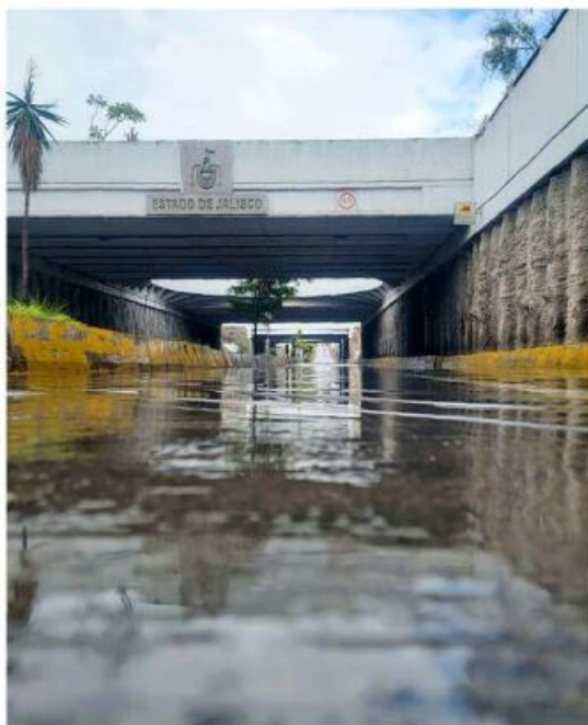
La tormenta, de 52 litros por metro cuadrado, inundó pasos a desnivel como el de La Calma.
