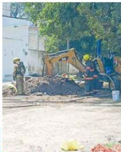
EN COYULA. Ayer se abrieron dos zanjas de contención para monitorear el subsuelo y mitigar riesgos.
