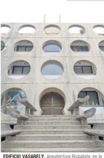
EDIFICIO VASARELY. Arquitectura Brutalista, en la Colonia Chapalita.
