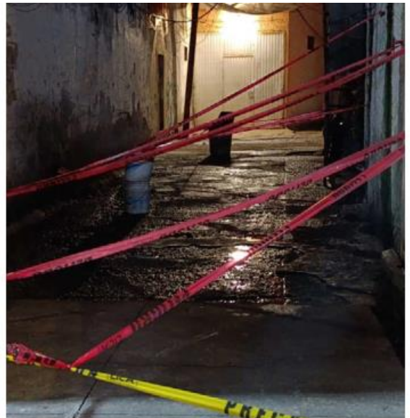
El socavón es de 8 metros de largo por 3 de ancho y una profundidad no determinada. VICENTE TORRES
