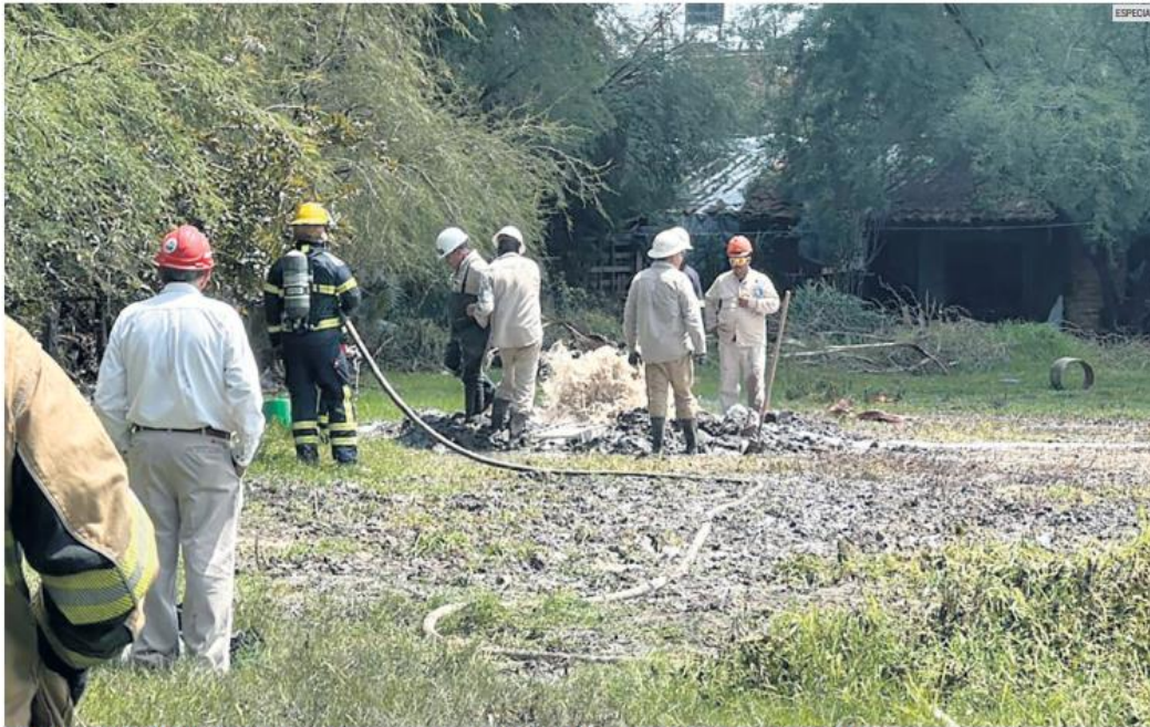
LABORES DE CONTENCIÓN. Durante todo el día se trabajó en la zona, ante las complicadas condiciones topográficas del ducto y el clima.
